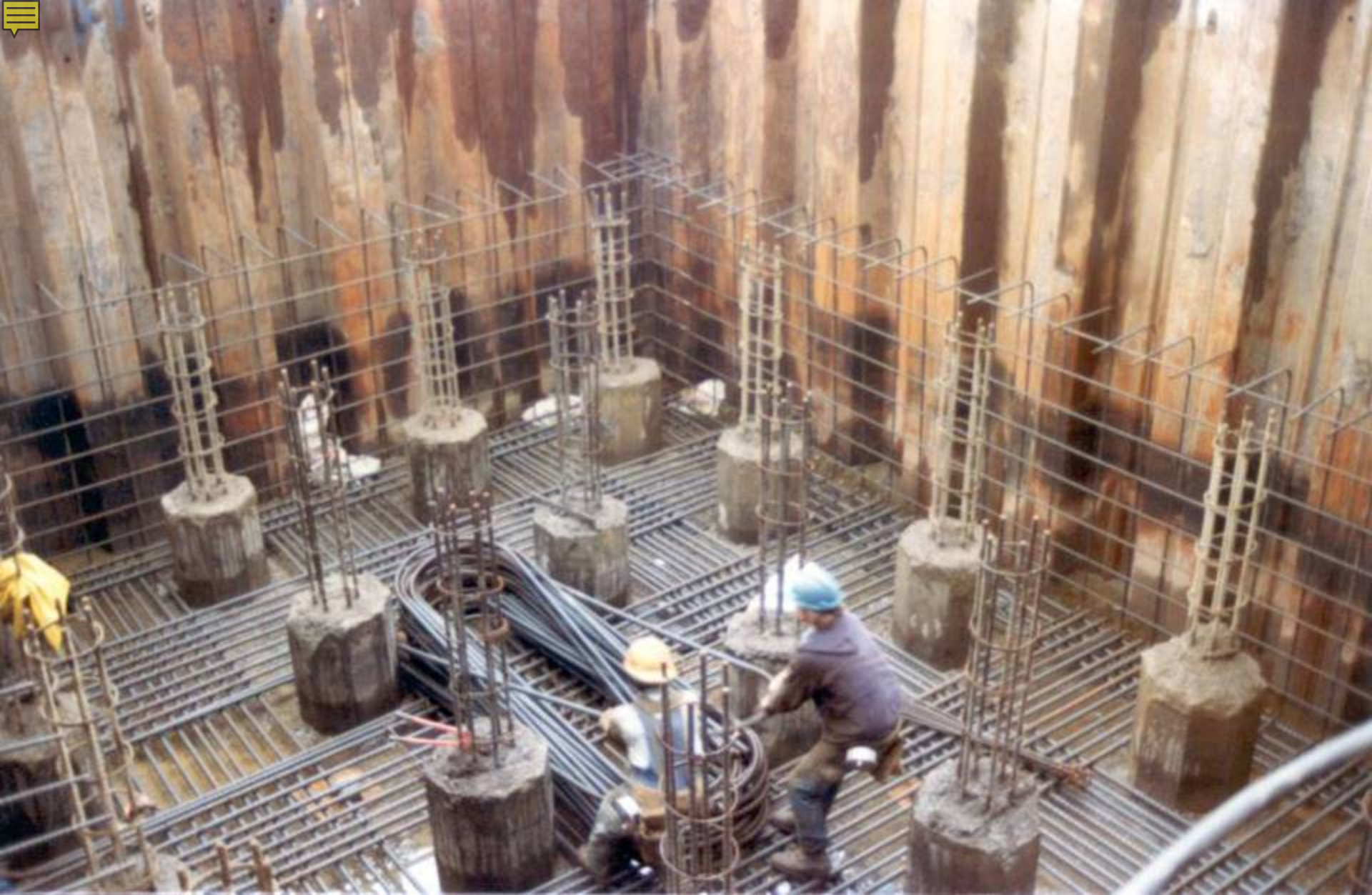
Octagon piles ready for final pour
